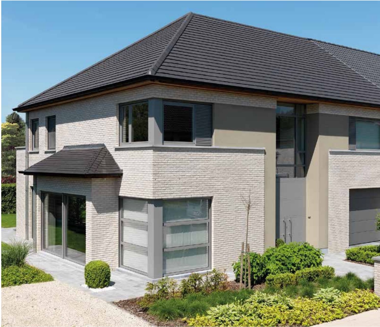
Facade : Domus Casa Lena
