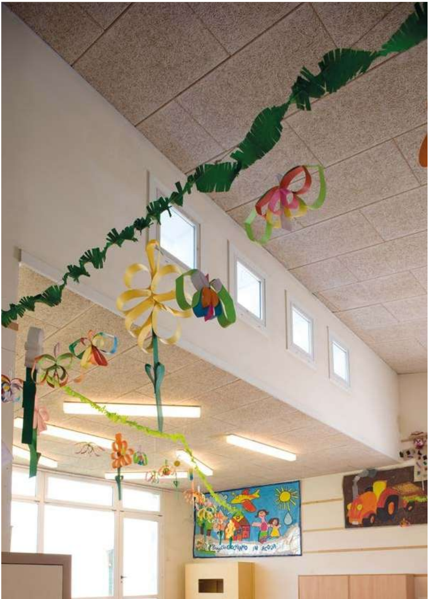
AMATORI INSTITUTE Vicenza, IT design: Caretta Carlo e Depau Liliana architetti | photo: Giovanni Porcellato
